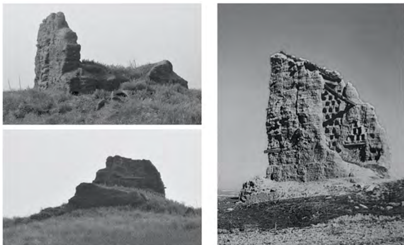
Figura 50. Imágenes del palomar moderno construido en tapial sobre la base de una torre de planta cuadrada. Puede apreciarse el mal estado de conservación y la degradación producida en unos pocos años, ya que las dos fotografías de la izquierda fueron tomadas en 2017 (Fuente: Daniel Justo Sánchez), mientras que la de la derecha aparece publicada en Gutiérrez González (1999: 96).
