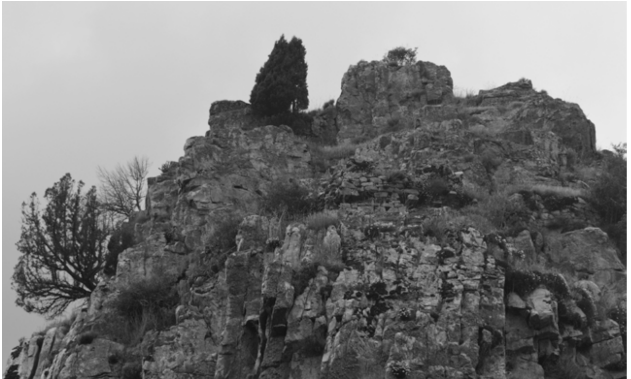
Figura 45. Parte oriental del peñasco donde fue construido el castillo de Luna, en la que pueden apreciarse algunos restos de mampostería. Fuente: Daniel Justo Sánchez.
